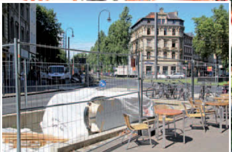
Unterirdischer Nahverkehr ist eine der Lösungen für die Zukunft. Hier wird eine U-Bahn-Haltestelle im öffentlichen Raum am Kölner Chlodwigplatz gebaut.
