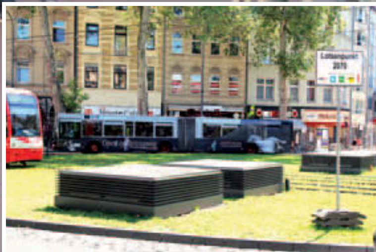
Kaum sichtbar zeugen die Be- und Entlüftungen der U-Bahn von einem ausgeklügelten System, das sich sanft ins Stadtbild einfügen soll.
